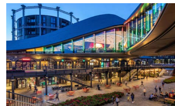
King's Cross, combinatie voorzieningen, verblijven en infrastructuur in Londen
