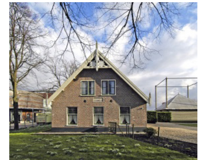
Hendrikskamp aan de Hoofdweg in Graan voor Visch Zuid als voorbeeld voor te behouden bebouwing en als verbijzondering (1861)
